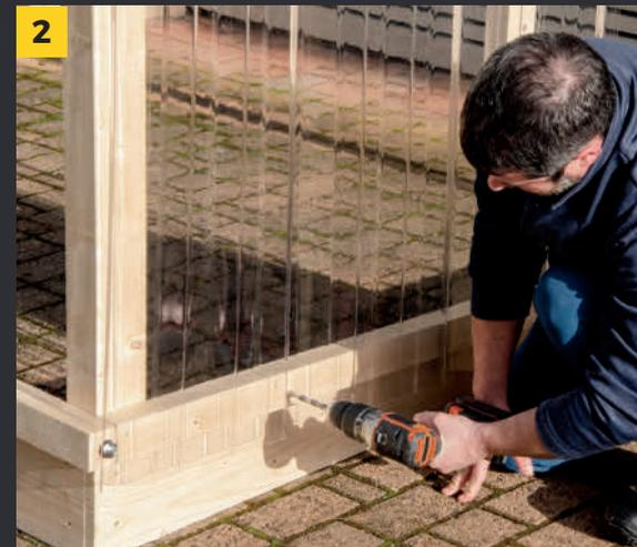
**3** La foratura (foro di 3 mm superiore al diametro della vite) è da fare con le lastre applicate nella corretta posizione, soprattutto nei punti di sormonto, dove i fori devono necessariamente combaciare in modo perfetto.
