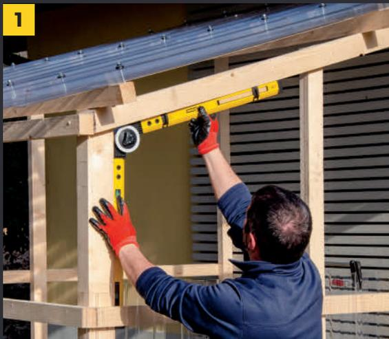
**1** Per assecondare la pendenza del tetto, si devono effettuare tagli inclinati; con la falsa squadra si rileva l'inclinazione precisa e si riporta sulla lastra, per marcarla nel modo corretto.
