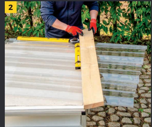
**3** Per marcare i tagli in squadra, presa la corretta misura, si usa sovrapporre una lastra integra per tracciare la linea di taglio, in modo da seguire con precisione tutti i rilievi.
